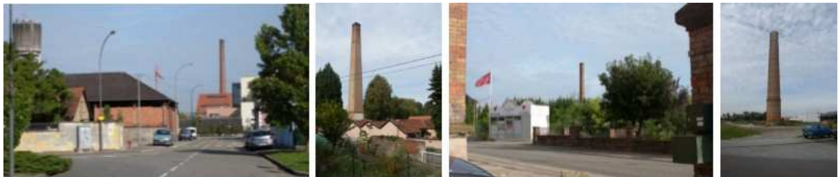
Cheminées de la chaufferie des établissements hospitaliers départementaux, de la manufacture Goetz, de la cartonnerie Seng rue des casernes, de la Société alsacienne de filature et tissage la Jute / Vestra
