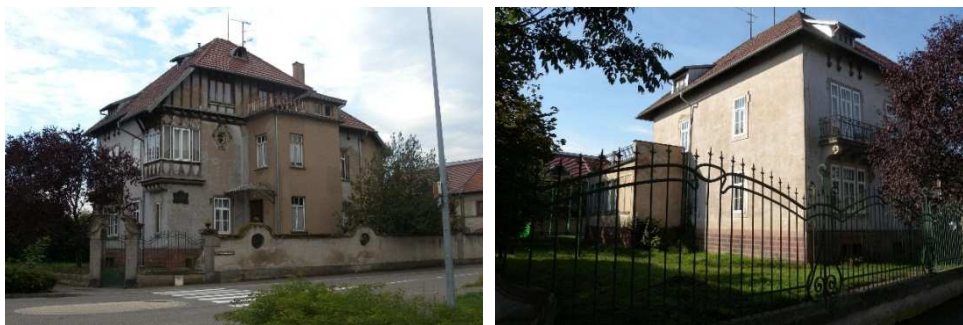
La villa Julia : façade Ouest sur rue des Prés (à gauche) et détail de clôture (à droite)
