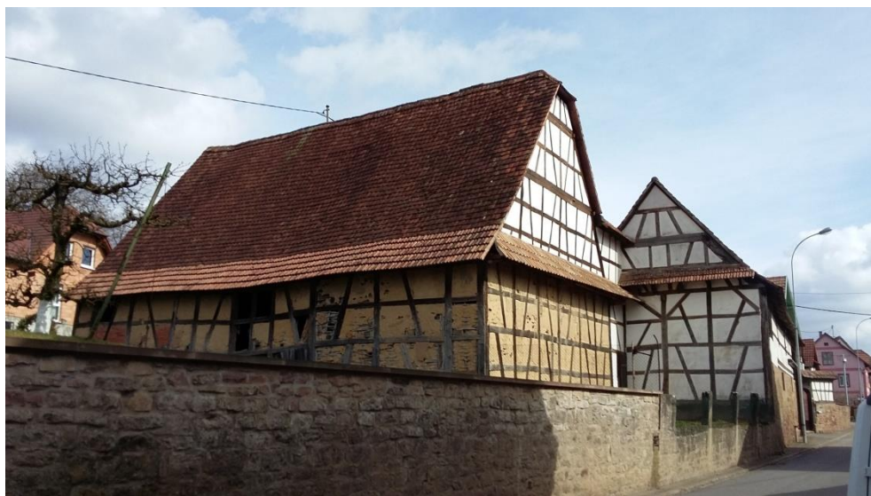
Exemple de bâtiment à réhabiliter
