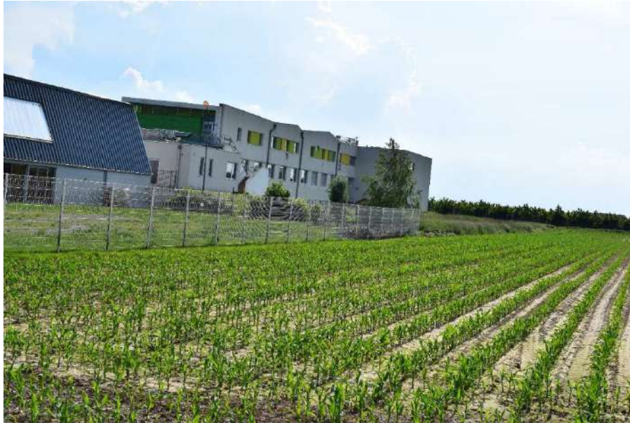
La façade arrière de l'école
