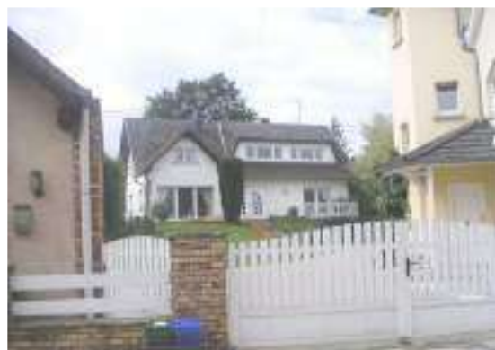
Rue de la Rivière : construction en deuxième rang. Source Altorffer sarl, Jérôme Espargilière
