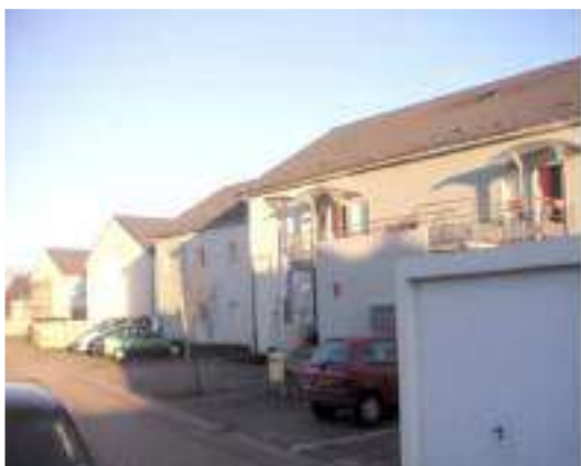
Logements locatifs aidés, à l'Est de la RD140. Source Altorffer sarl, Jérôme Espargilière
