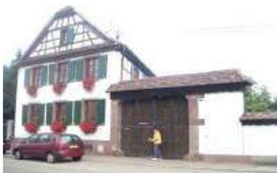
Rue Krautwiller : portail ancien préservé. Source Altorffer sarl, Jérôme Espargilière
