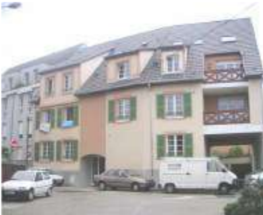
Collectif, rue des Bergers, bien intégré au tissu existant. Source Altorffer sarl, Jérôme Espargilière
