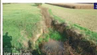
Vue vers l'aval
