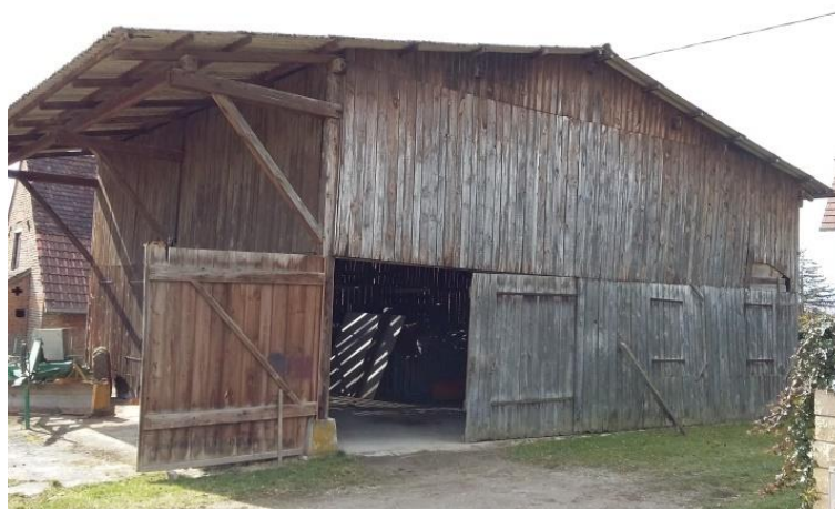
Ateliers municipaux, dans un bâti dont les configurations sont très proches des anciennes exploitations agricoles, en plein cœur du village
