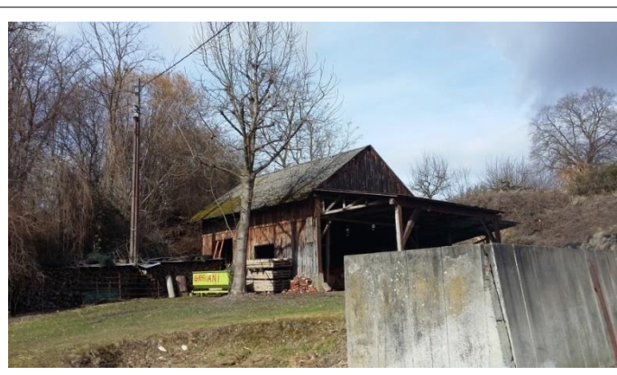
Exemple de dent creuse en centre ancien – projet en cours
