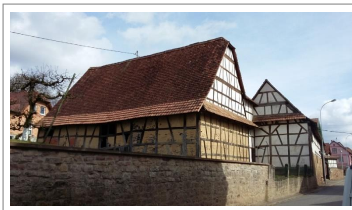
Exemple de bâtiment à réhabiliter en centre ancien
