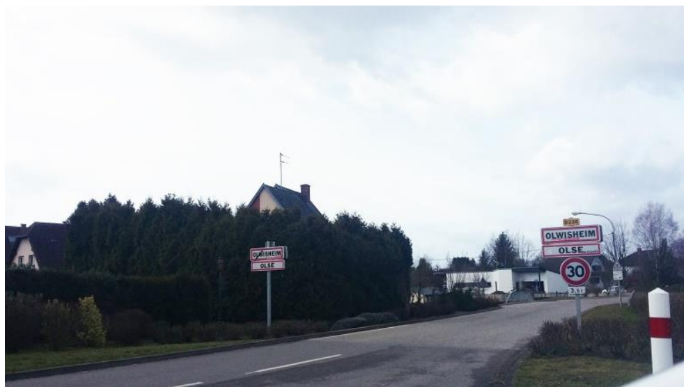
Entrée Est de la commune
