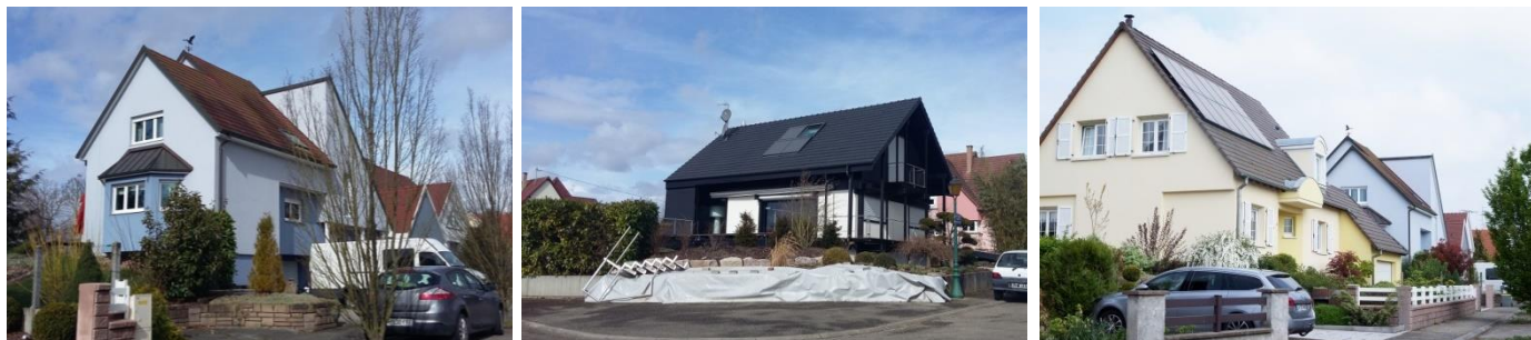
Exemples de constructions - bâti organisé
