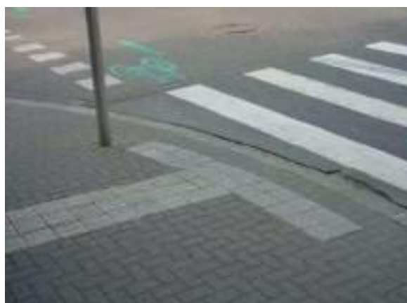
Exemple de guidage vers un passage protégé
