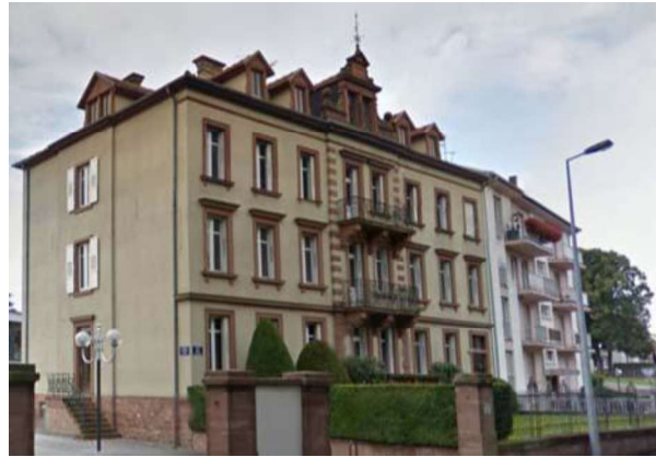
Vue d'ensemble depuis la voie publique de l'immeuble situé 4 Place Schuman. (Source : Google – 2014)
