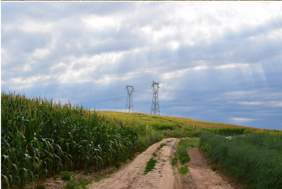
Le passage du couloir de lignes électriques en bordure du plateau.
