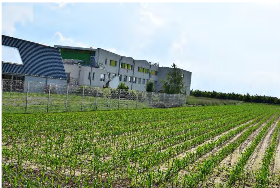
La façade arrière de l'école
