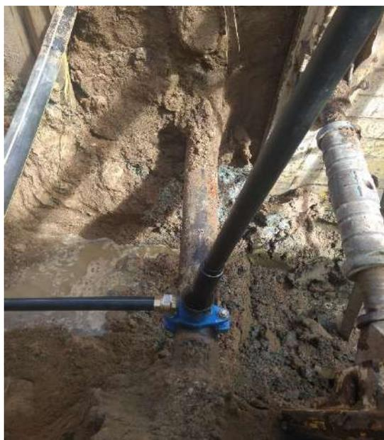
Raccordement d'un branchement sur la conduite principale
