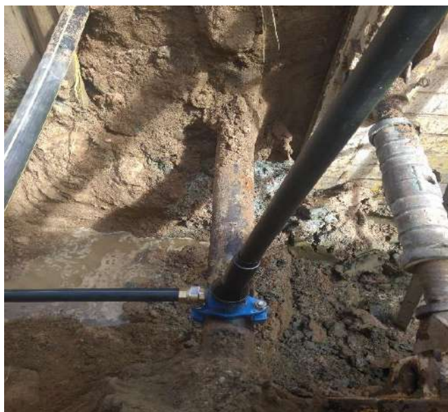
Raccordement d'un branchement sur la conduite principale
