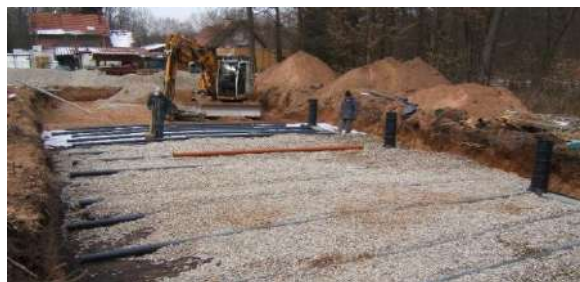
Vue d'un lit d'épandage, en phase de construction
