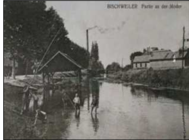
Les berges de la Moder à Bischwiller au début du 20 ème siècle : le cours d'eau jouait un rôle important dans la ville ; aujourd'hui il n'est plus véritablement mis en valeur. Source : archives municipales de Bischwiller
