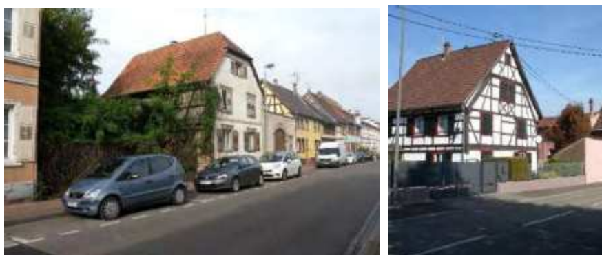
Immeubles à pans de bois en pignon sur rue : rue des Charrons (à gauche) et rue Paul Weiss à Hanhoffen (à droite).
