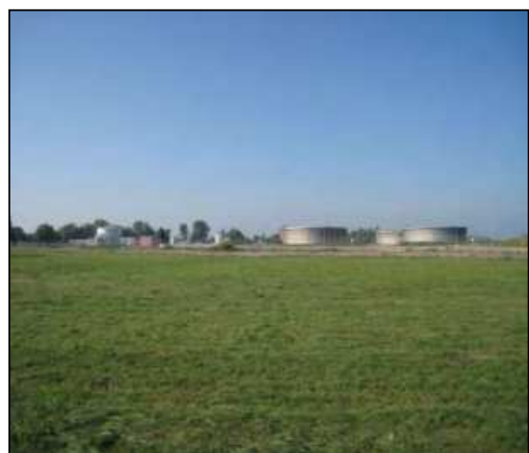
Dépôt pétrolier d'Oberhoffen : un impact visuel fort au sein des paysages ouverts du Ried
