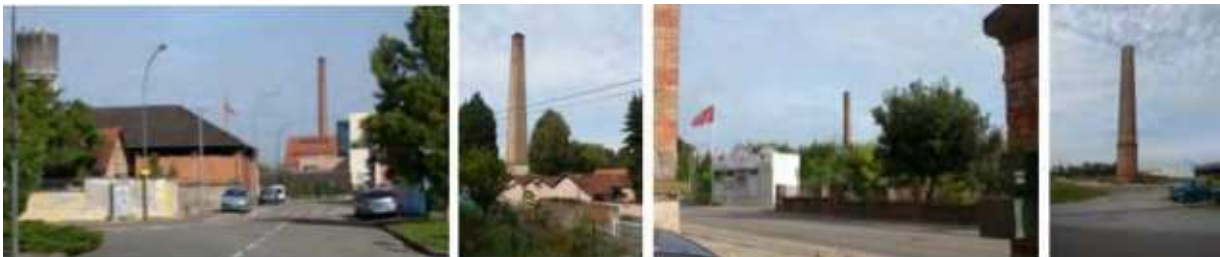
Cheminées de la chaufferie des établissements hospitaliers départementaux, de la manufacture Goetz, de la cartonnerie Seng rue des casernes, de la Société alsacienne de filature et tissage la Jute / Vestra
