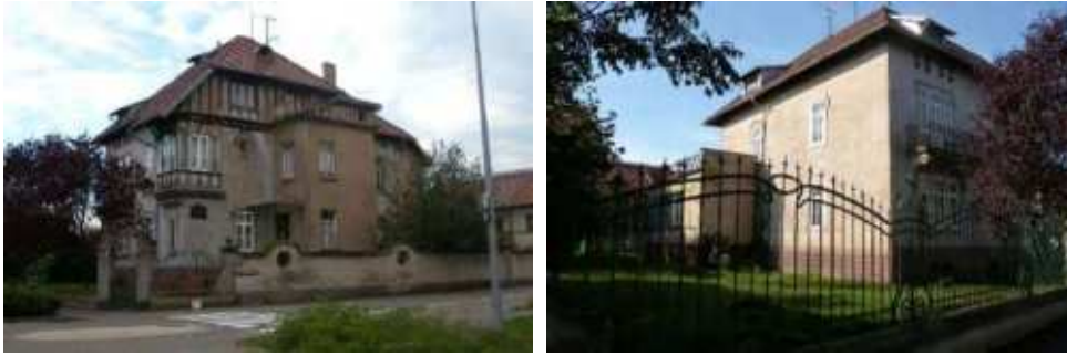
La villa Julia : façade Ouest sur rue des Prés (à gauche) et détail de clôture (à droite)
