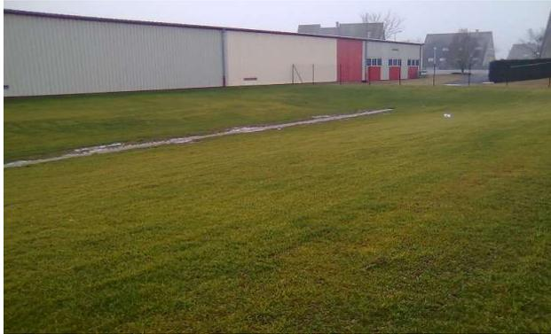
Également dénommés bassins d'orage, ces ouvrages permettent de stocker le flot de rinçage des réseaux unitaires ou d'écrêter les débits par temps de pluie, puis de restituer ces eaux de manière limitée en direction des stations d'épuration. Le réseau de Haguenau dénombre **10 bassins de rétention de type unitaire**.
